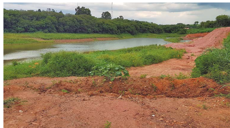
Nas últimas semanas as obras foram interrompidas sem qualquer esclarecimento a respeito
